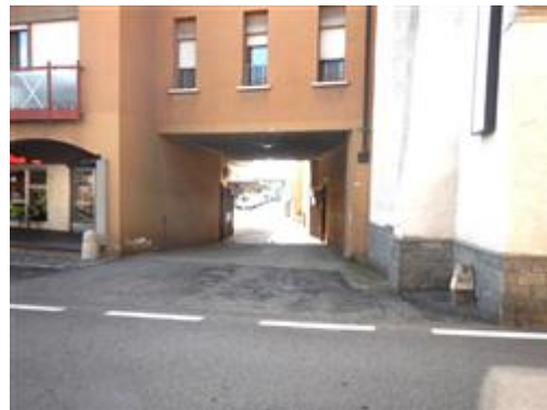
INGRESSO CARRAIO DA VIA SANT'AMBROGIO
