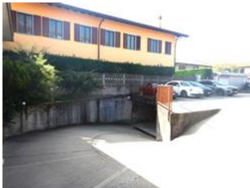
RAMPA DI ACCESSO AL BOX
