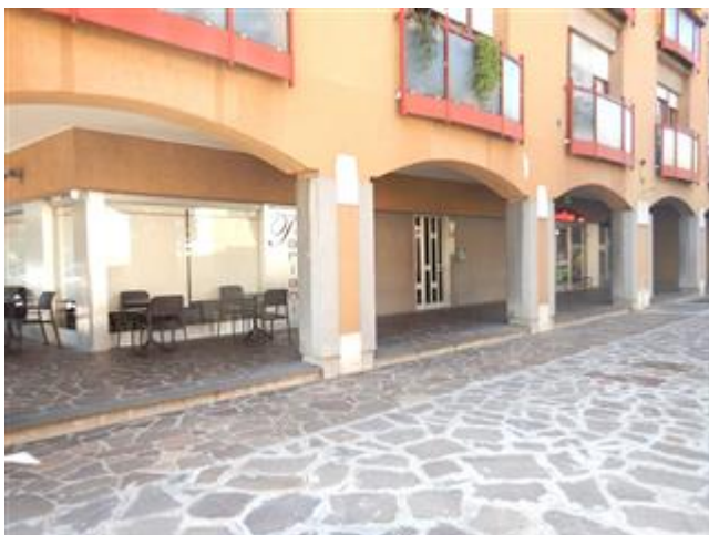
INGRESSO ATRIO CONDOMINIALE
