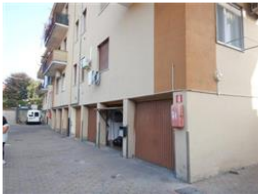
vista dal corsello box
