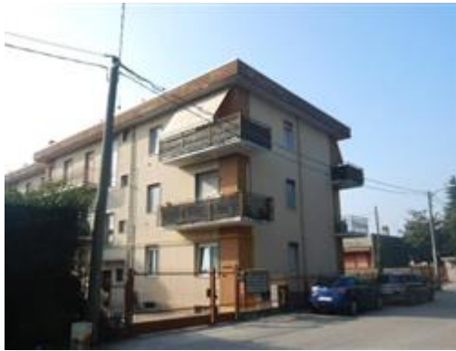
ingresso da via Giusti 11
