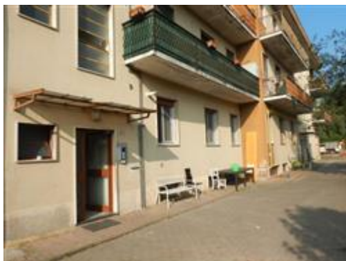
accesso alla scala a servizio dell'abitazione
