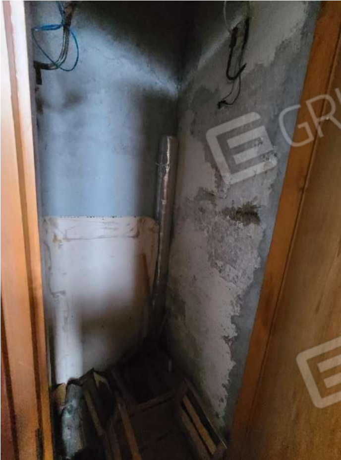
Vano caldaia P. Terra (vuoto)
