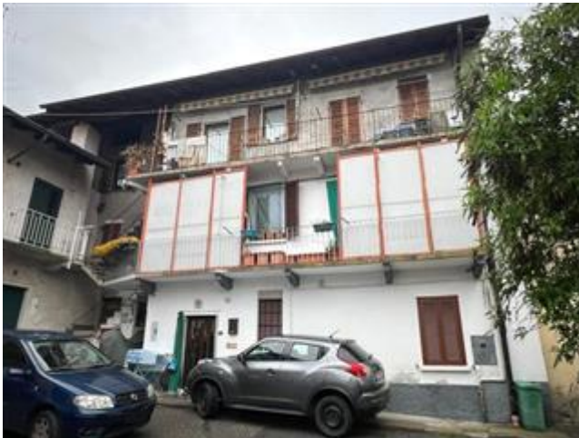
Foto facciata esterna su Via Cadorna
