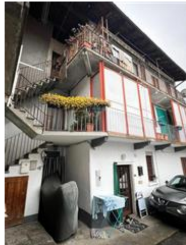
Foto facciata esterna su Via Cadorna
