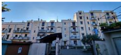
Vista dell'edificio condominiale
