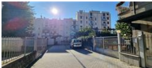
Vista del corsello di accesso all'edificio condominiale
