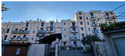
Vista dell'edificio condominiale
