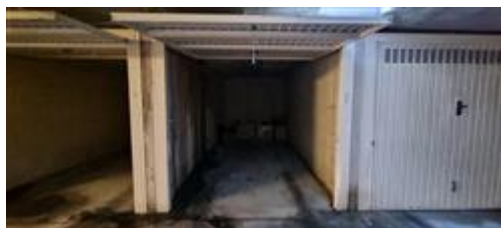
Vista dell'accesso al locale autorimessa
