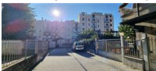
Vista del corsello di accesso all'edificio condominiale
