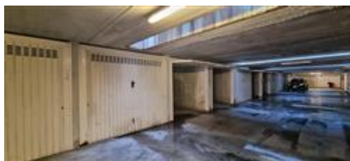
Vista del corsello comune e dell'accesso al box
