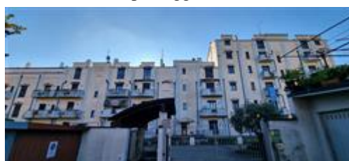
Vista dell'edificio condominiale
