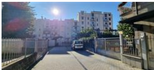
Vista del corsello di accesso all'edificio condominiale
