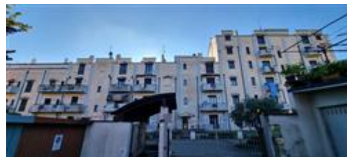
Vista dell'edificio condominiale
