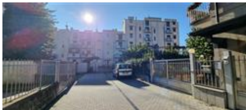
Vista del corsello di accesso all'edificio condominiale
