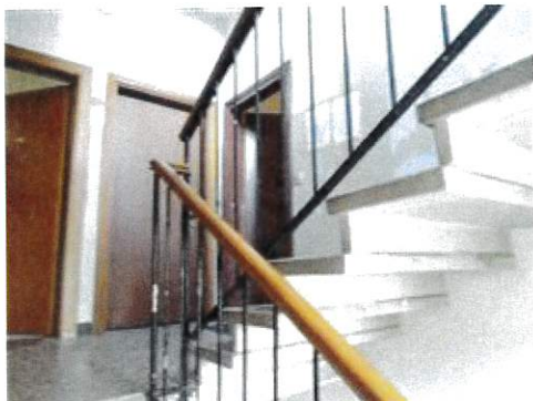
Vista scala interna e porta ingresso appartamento
