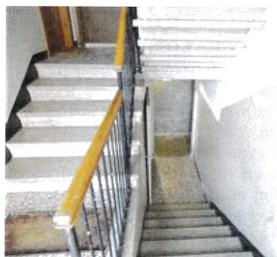
Vista scala interna e ingresso cantina
