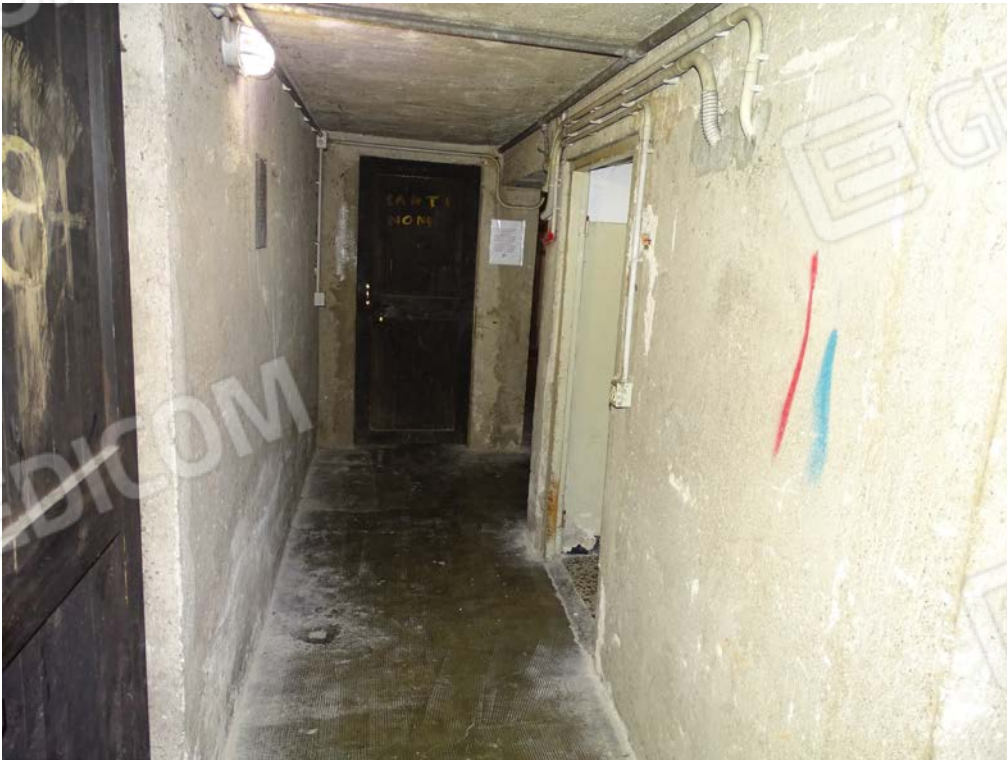
Vista corridoio cantina
