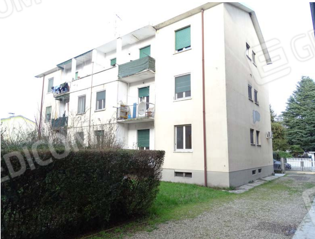
Vista dal cortile interno
