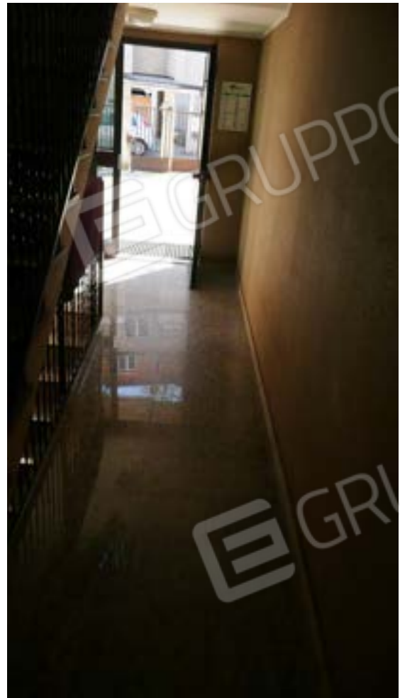
VANO DI INGRESSO E SCALA
