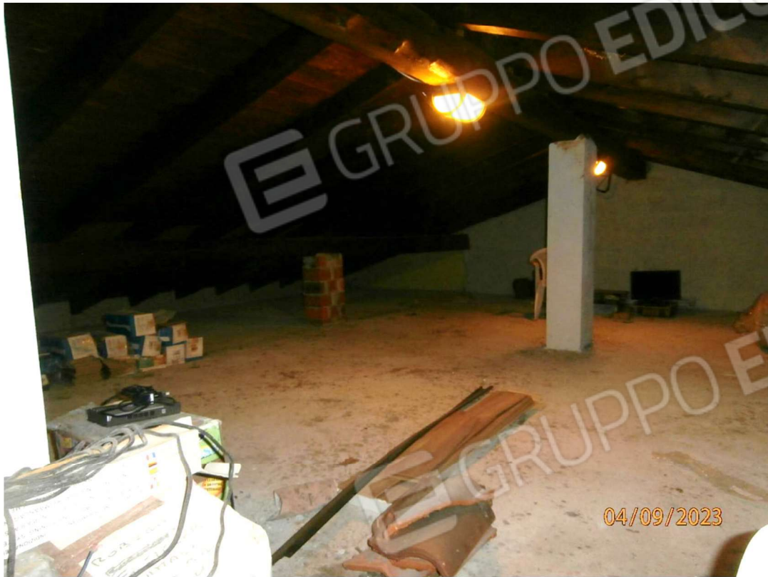
Vista interna sottotetto accessibile e non abitabile
