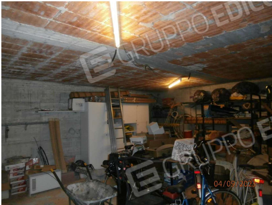
Vista interna locale rustico a piano interrato
