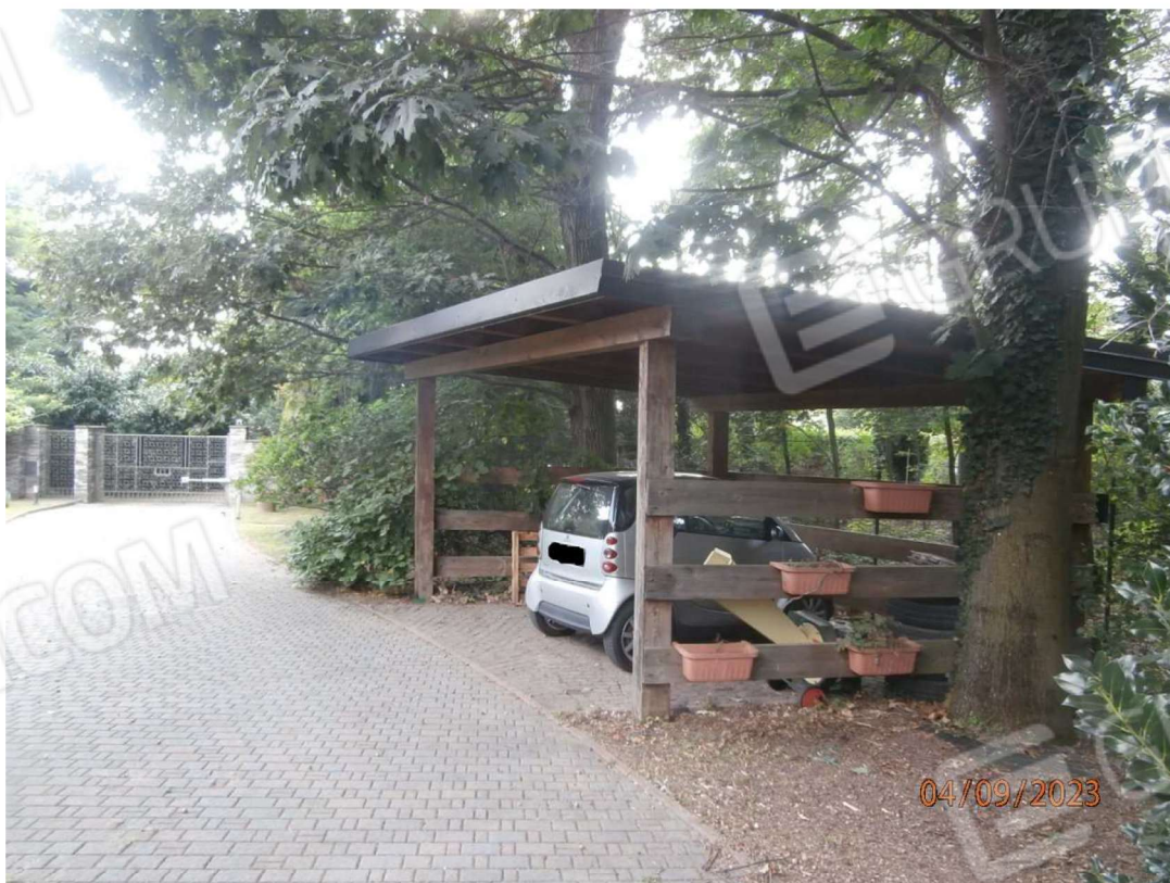
Vista tettoia non regolare
