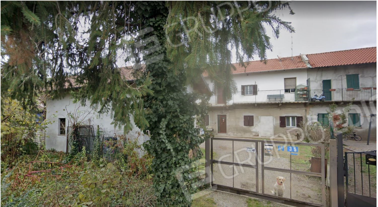
CANCELLO PESONALE E CARRAIO DI INGRESSO ALLA PROPRIETA'
