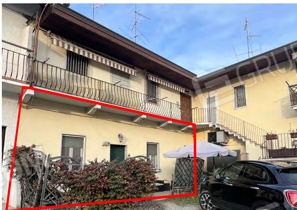
Facciata su cortile oggetto di pignoramento
