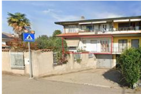
vista da via G. Verdi
