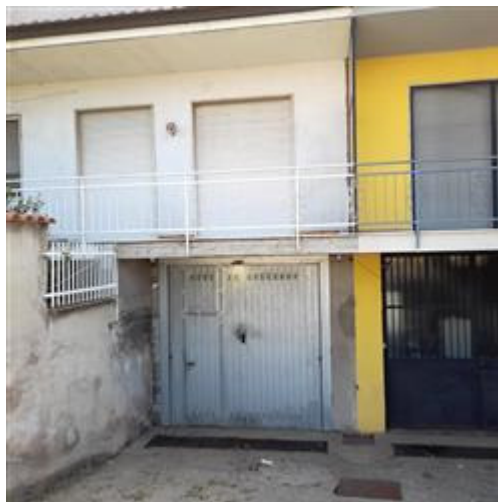
vista da via G. Verdi
