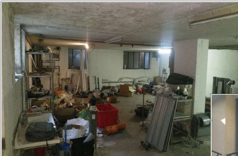
Il grande locale scantinato dove si possono notare fenomeni infiltrativi sul plafone
