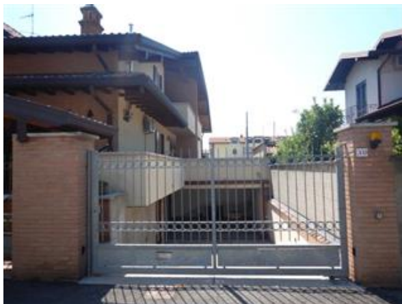
vista ingresso carraio su via Alfredo Di Dio
