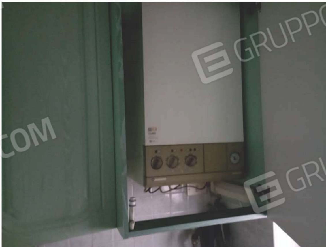
F18 DETTAGLIO – CALDAIETTA MURALE RISC./ACS CORPO A
