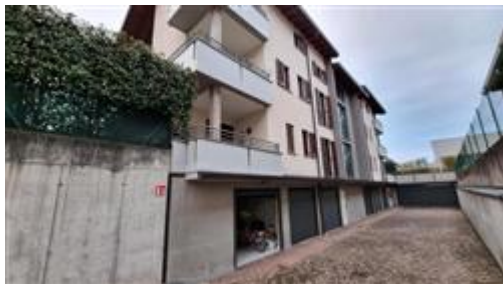
rampa ingresso carraio e prospetto posteriore
