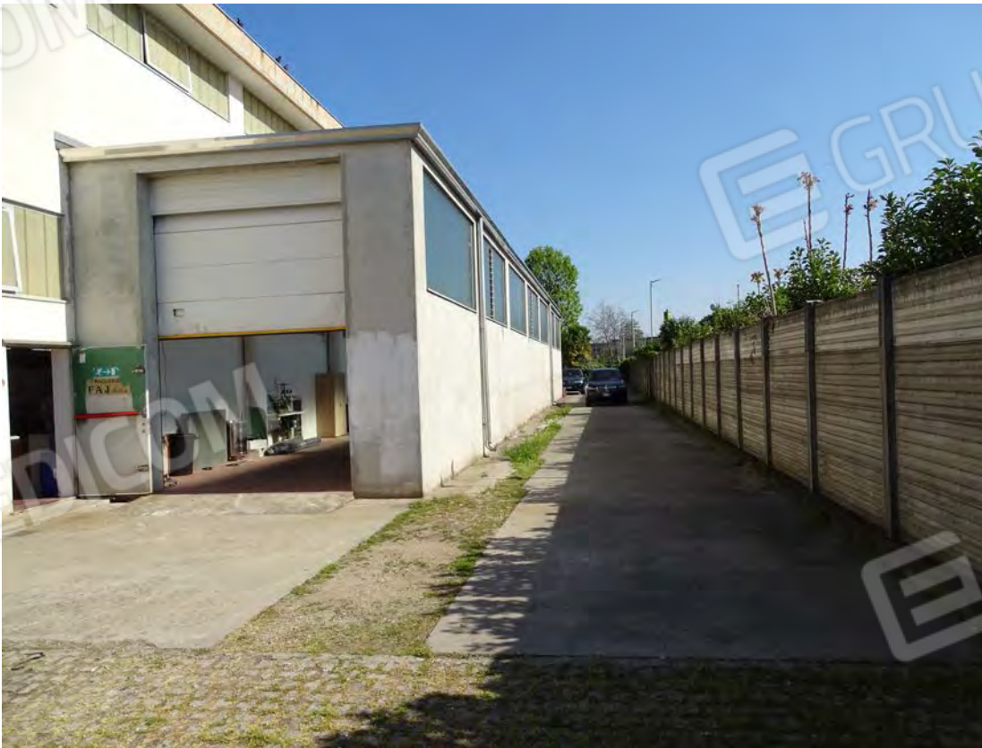
VISTA INTERNA CORTILE
