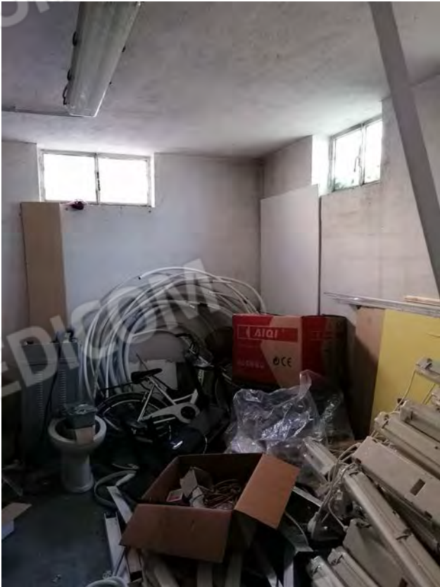
VISTA LOCALE CANTINA
