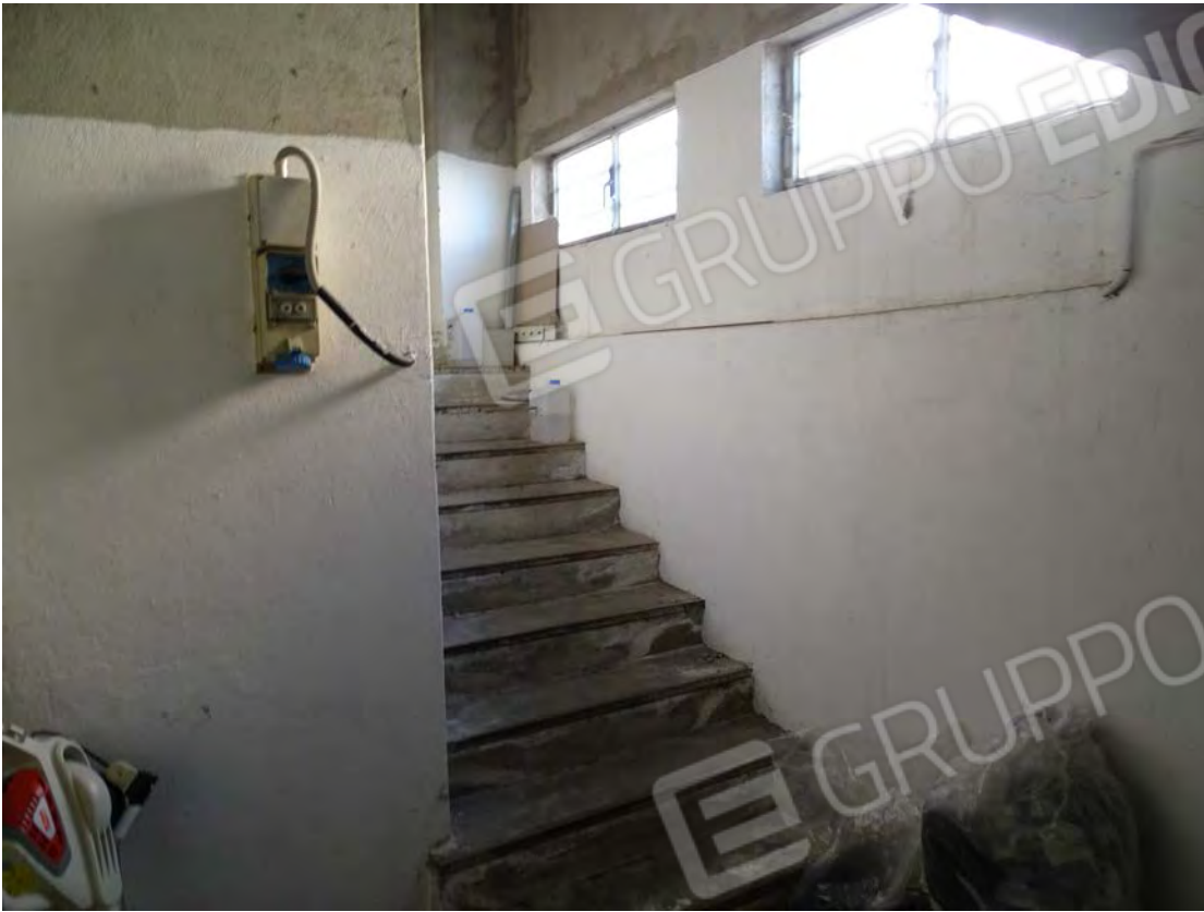
VISTA LOCALE CANTINA
