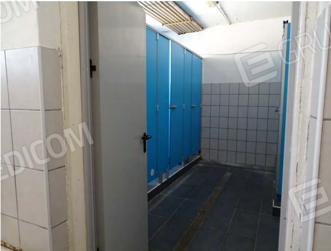
VISTA BAGNI PIANO PRIMO
