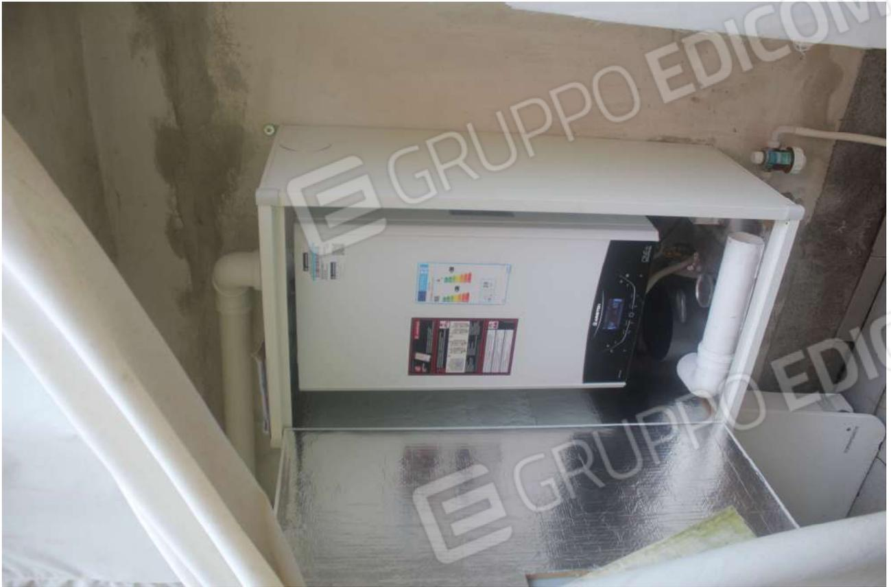
Foto 15 – Particolare caldaia a servizio dell'unità
