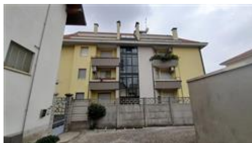
Vista dell'edificio - prospetto NORD-OVEST
