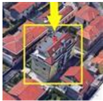
Angolo Nord dell'edificio di via Bernina n.3
