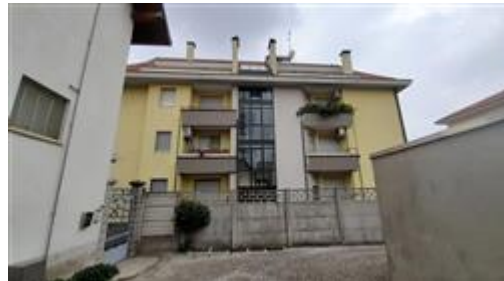
Vista dell'edificio - prospetto NORD-OVEST
