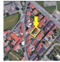
Individuazione edificio di via Bernina n.3
