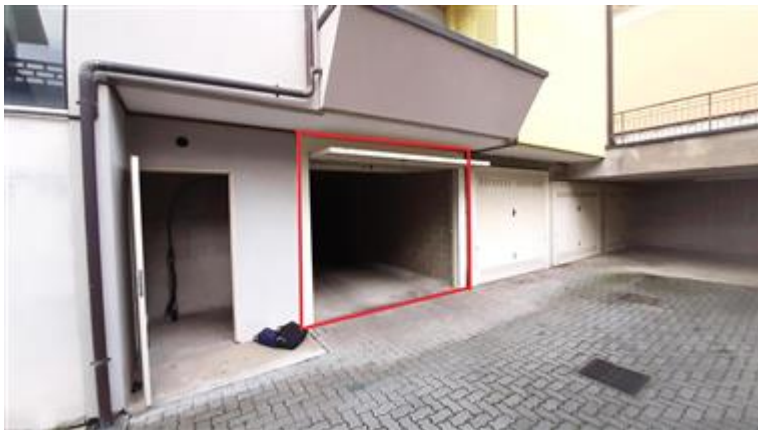
Vista da corsello di manovra
