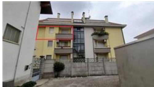
Vista dell'edificio - prospetto NORD-OVEST - con evidenziata l'u.i. in questione
