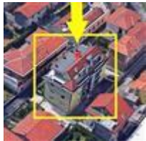
Angolo Nord dell'edificio di via Bernina n.3
