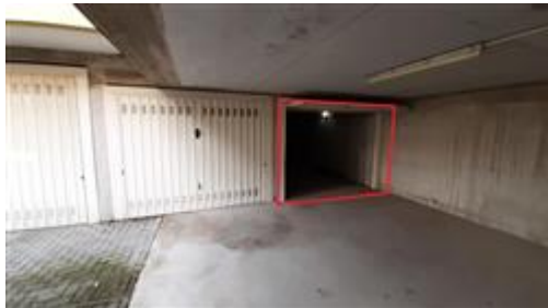
Vista da corsello di manovra
