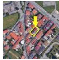
Individuazione edificio di via Bernina n.3
