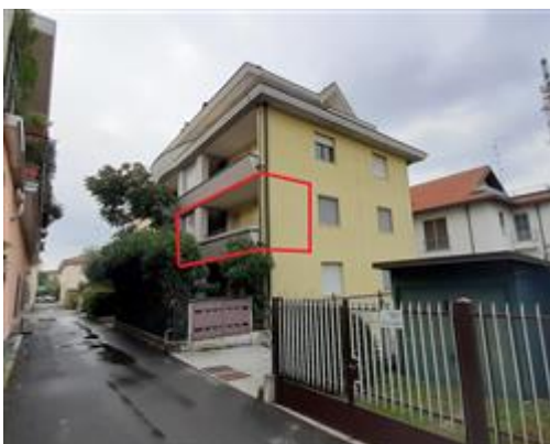
Vista dell'edificio - angolo EST - via Bernina - con evidenziata l'u.i. in questione
