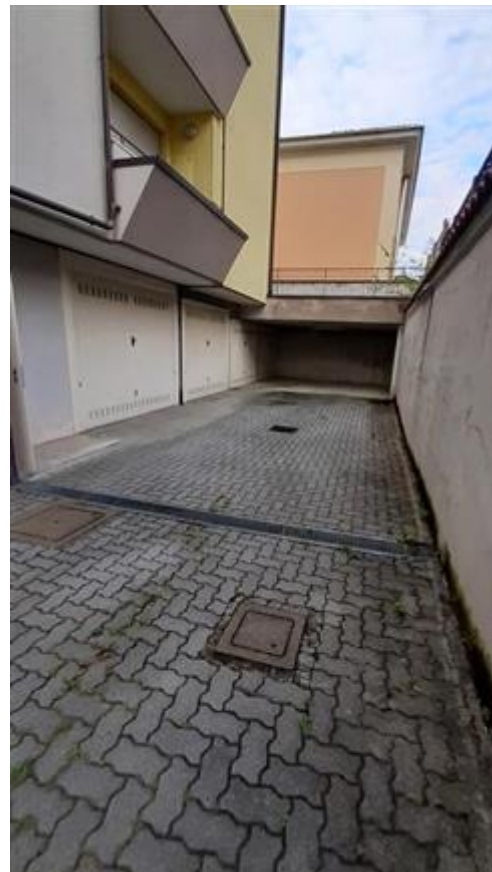
Vista corsello di manovra del fabbricato cui appartiene l'u.i. oggetto di stima
