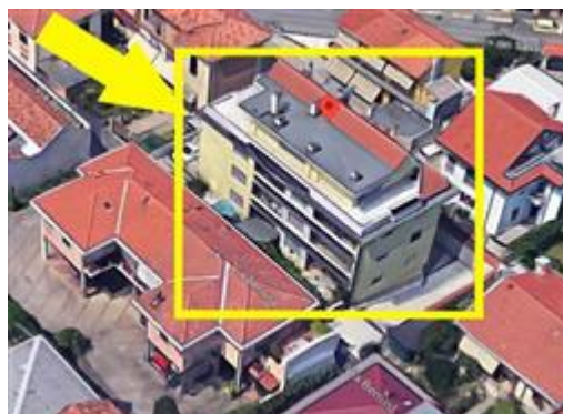
Vista aerea dell'edificio di appartenenza dell'u.i. oggetto di stima - angolo EST
