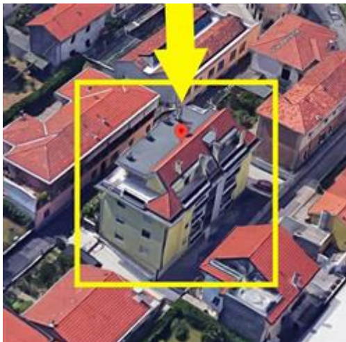
Vista aerea dell'edificio di appartenenza dell'u.i. oggetto di stima - angolo EST
