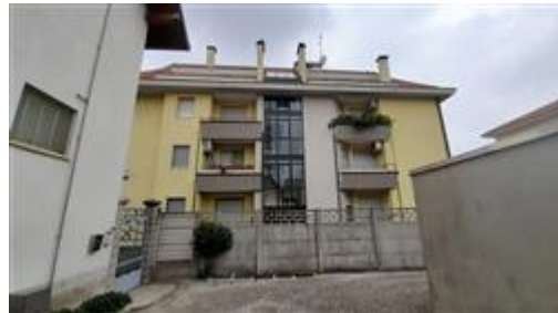
Vista dell'edificio - prospetto NORD-OVEST
