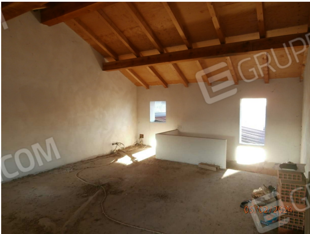
Vista interna a piano sottotetto
