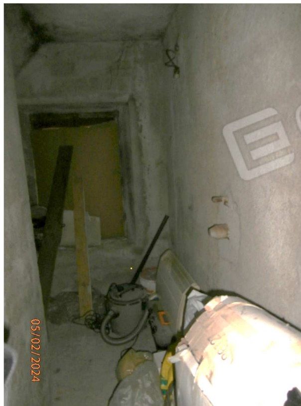
Vista interna bagno 2 rustico a piano primo
