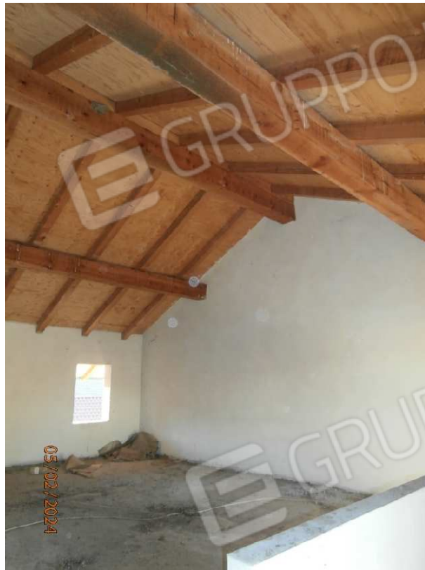
Vista interna a piano sottotetto
