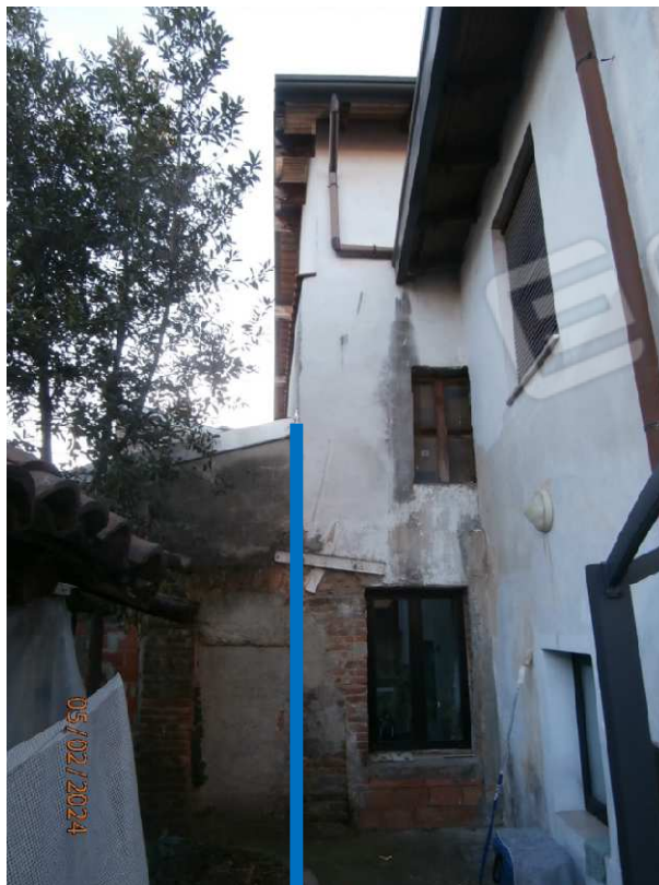
Vista esterna immobile dal cortile di proprietà (in blu limite proprietà)
