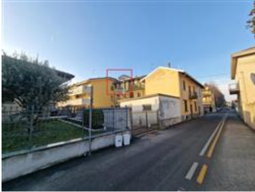
Vista esterna zona ingresso appartamento
