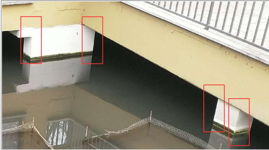
I “copriferrì” (riquadri rossi) non sembrano soggetti a fenomeni di degrado, ma occorre che la vasca sia svuotata per verificare la parte ora immersa e non visibile causa acqua sporca e torbida.
