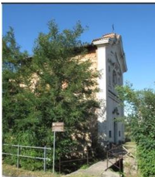
Chiesina di San Marco detta DEL LAZZARETTO, eretta nel 1721, centenario della "Peste dei Promessi Sposi". Già presente nel catasto Teresiano.
