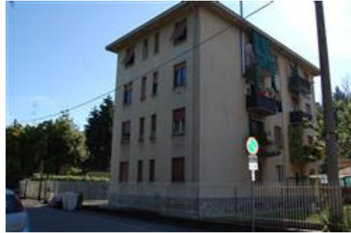
prospetto sud-ovest da via Greppi
