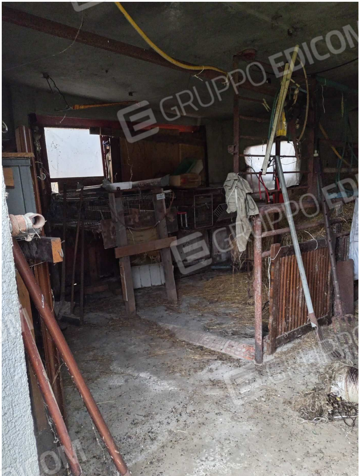
Foto 10 – rustico foglio 1 particella 51 – interno (lotto 3)
