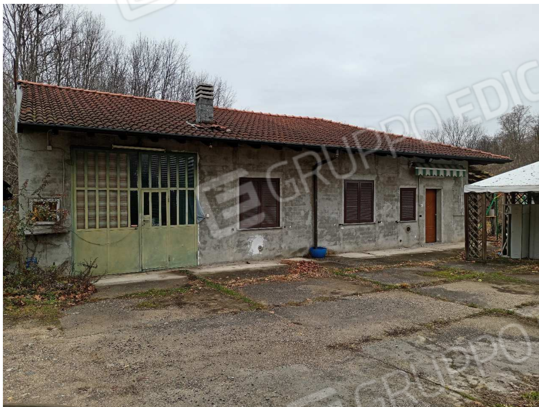
Foto 3 – abitazione foglio 1 particella 43 sub 501 (lotto 2)
