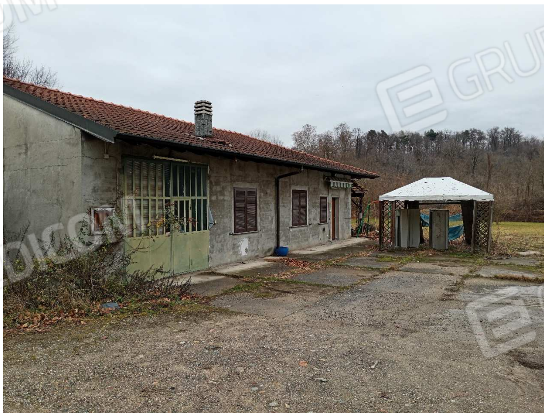
Foto 2 – abitazione foglio 1 particella 43 sub 501 (lotto 2)
