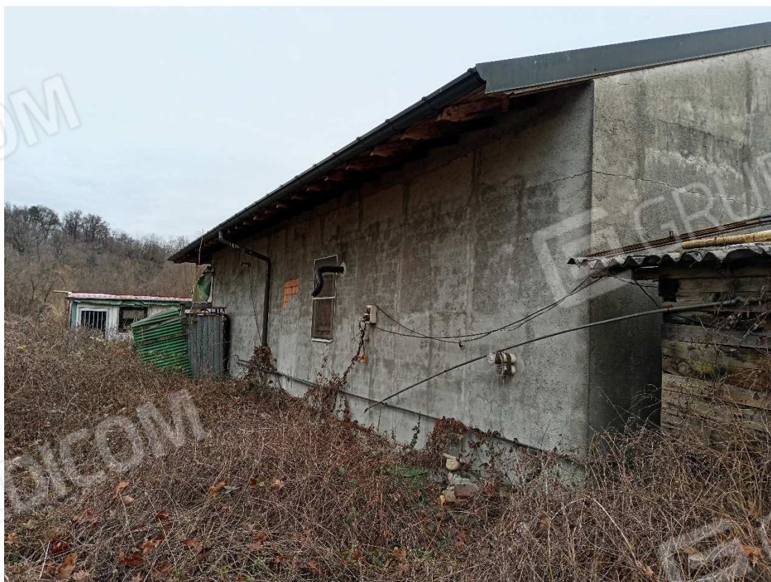
Foto 4 – altra vista abitazione foglio 1 particella 43 sub 501 (lotto 2)
