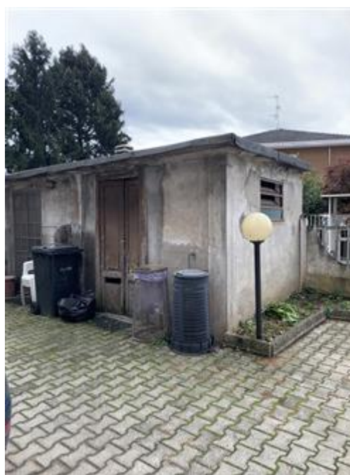
Ripostiglio piano terra
