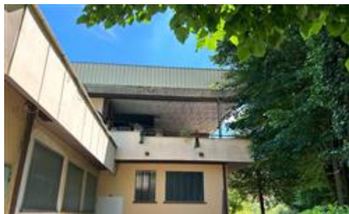
esterno lato ovest
