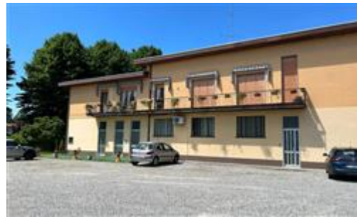
esterno lato ovest
