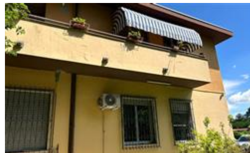
esterno lato sud
