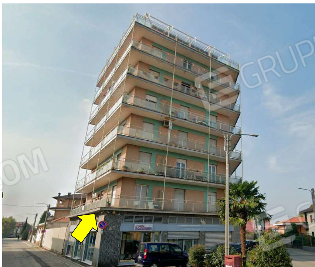
IL CONDOMINIO NEL QUALE INSISTE L'APPARTAMENTO AL PIANO TERRA CON IL GIARDINO IN USO ESCLUSIVO (immagine tratta da Google Earth)
