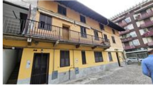
prospetto su cortile comune
