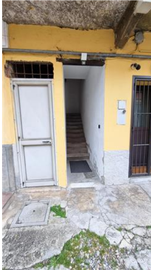
andito ingresso alla scala comune
