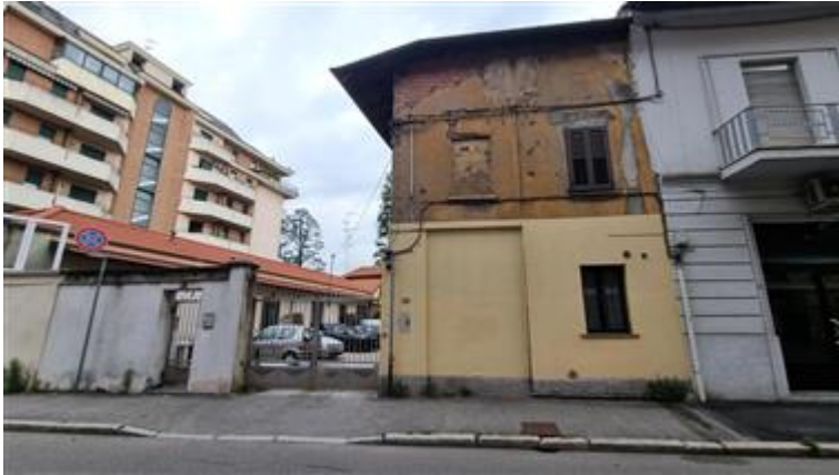
facciata su Via Gavinana in scarso stato manutentivo
