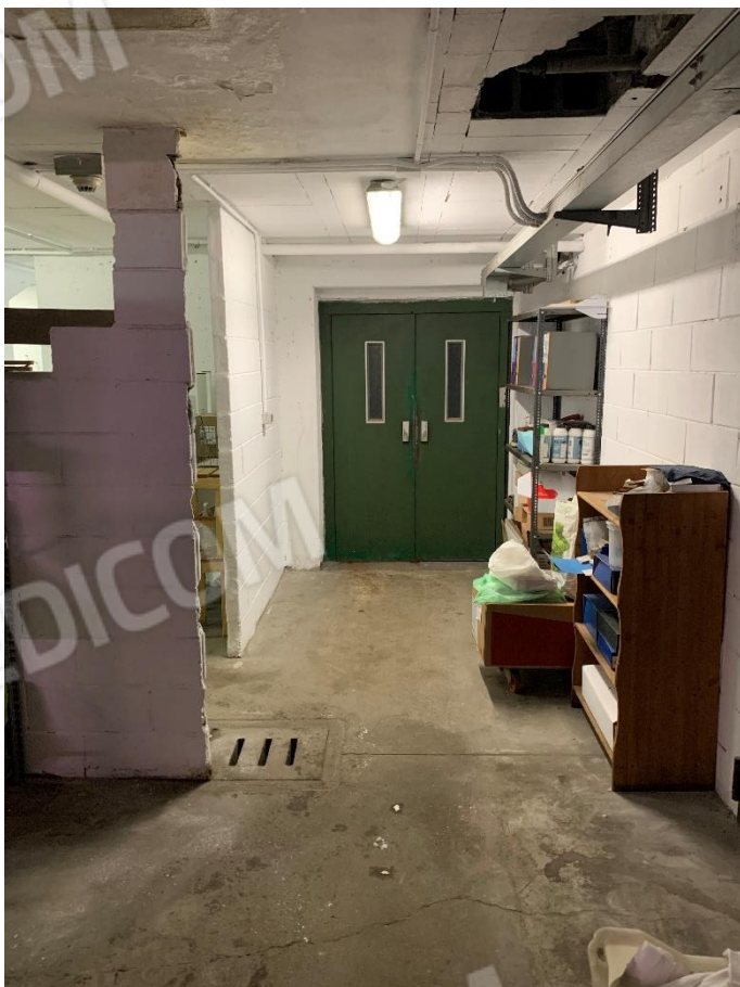
12 zona piano interrato
