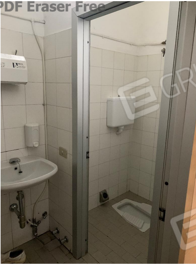
09 zona bagni/spogliatoi piano terra
