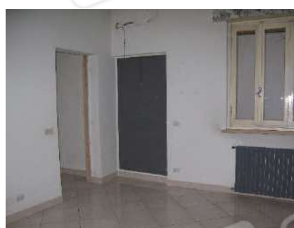
Foto 8 – Interno – Camera (P1)
