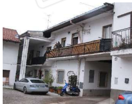
Foto 2 – Esterno – Vista da corte comune Fronte sud
