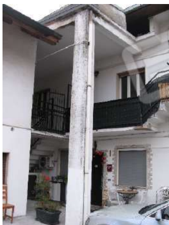
Foto 3 – Esterno – Fronte sud e scala esterna comune
