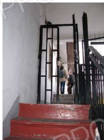
Foto 4 – Esterno – cancello d'ingresso al piano appartamento
