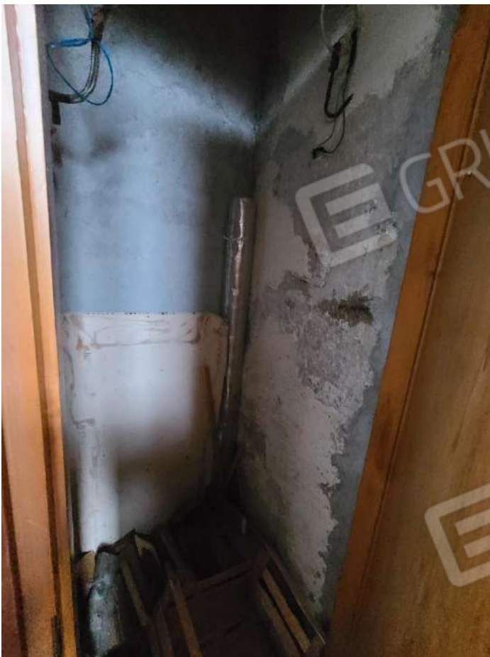
Vano caldaia P. Terra(vuoto)
