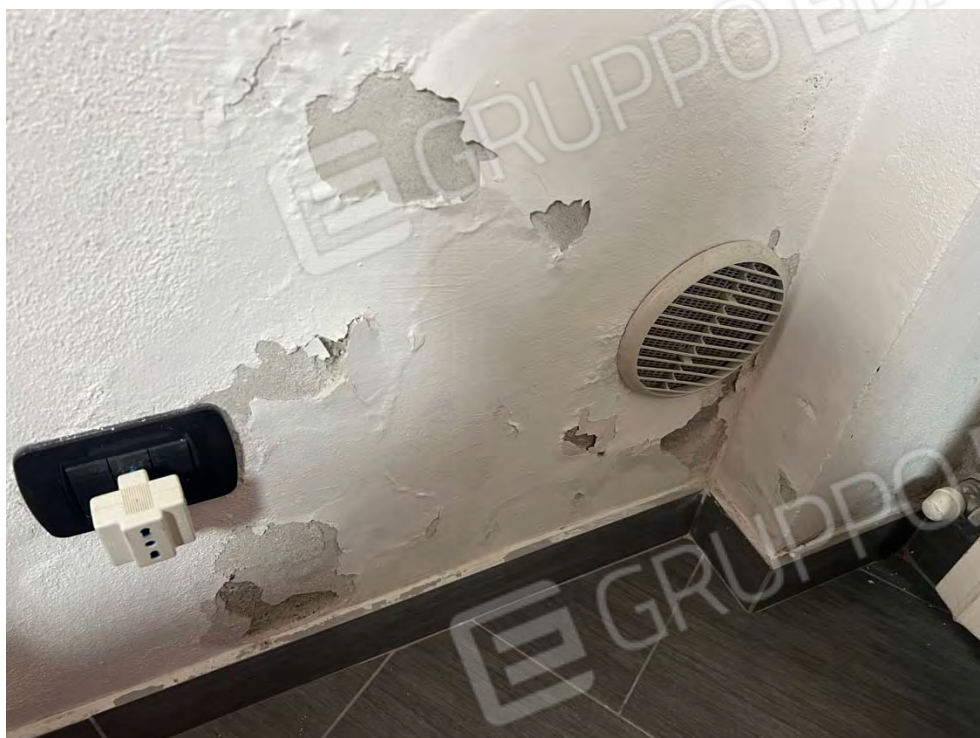
Scrostamento zoccolo interno
