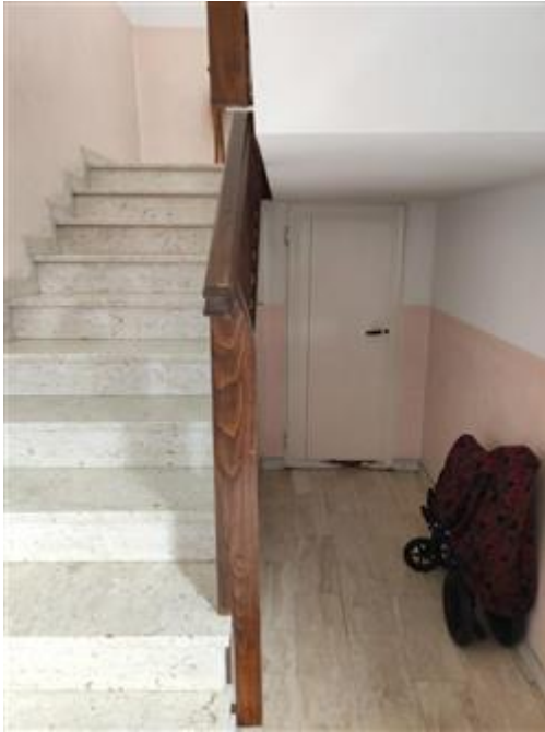
SCALA P.T.E ACCESSO INTERNO AL PIANO SEMINTERRATO
