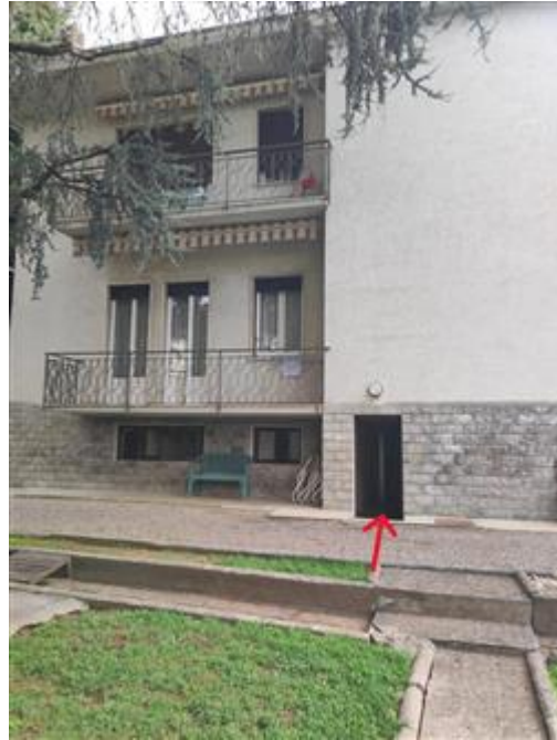
ACCESSO ESTERNO AL PIANO SEMINTERRATO
