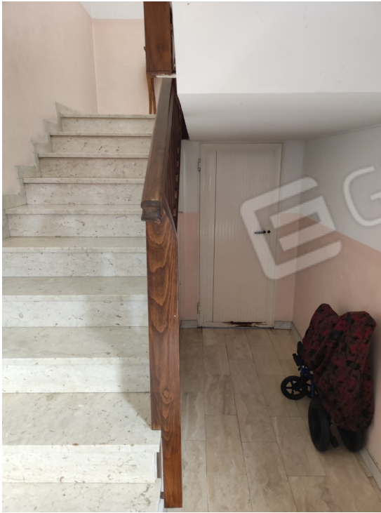
Scala e accesso al seminterrato
