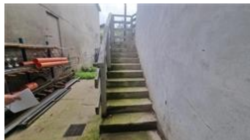
scala esterna tra p.t e p. 1
