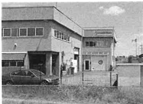
facciata dalla via Sampietro, porta pedonale e accesso carrabile
