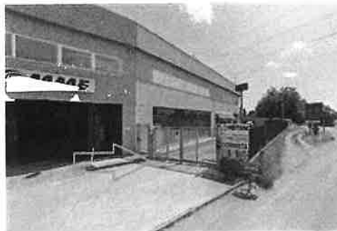
cancello pedonale e carrabile di accesso dalla via Sampietro
