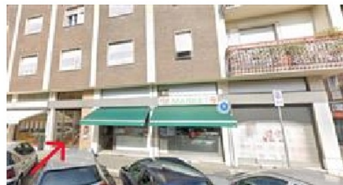
Vista esterna con ingresso al vano scala
