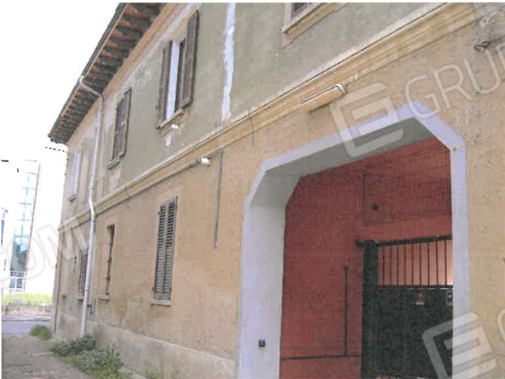
Accesso al fabbricato
