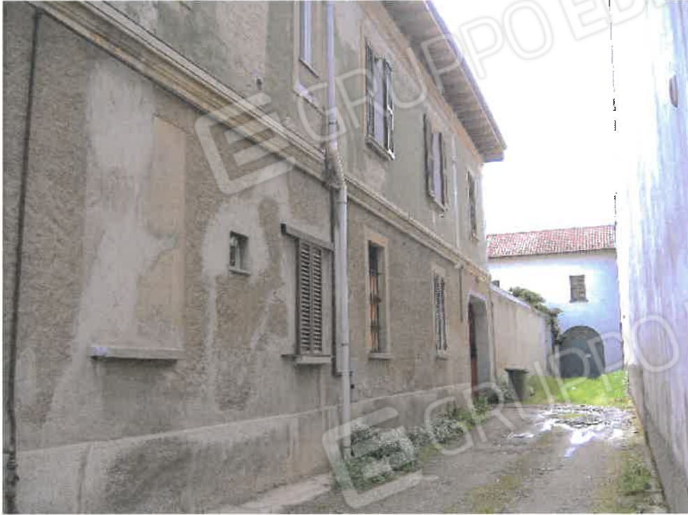
Accesso al fabbricato da strada interna
