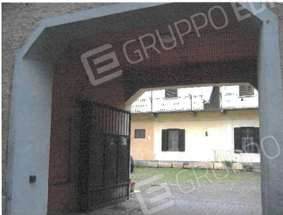
Accesso al fabbricato
