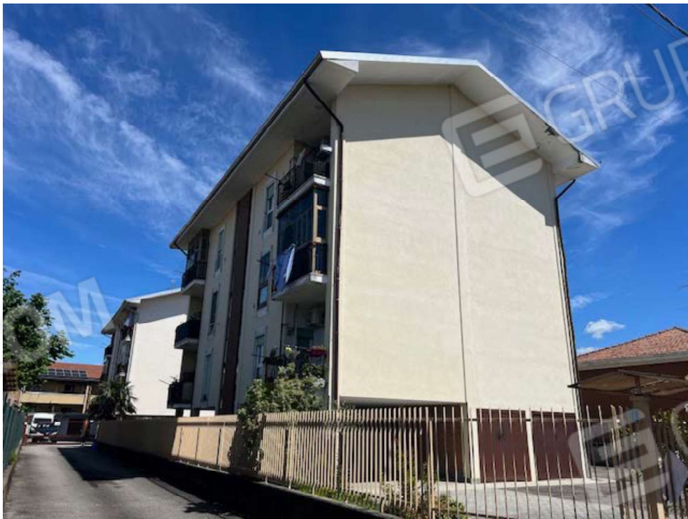
Fronte nord Via privata ed ovest su Via Milano
