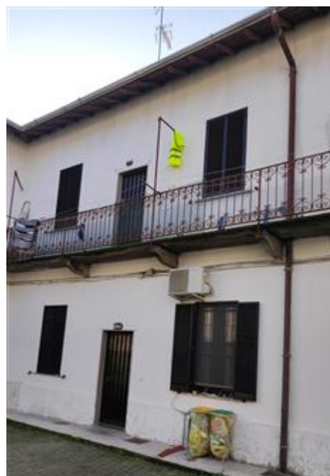
particolare facciata esterna abitazione
