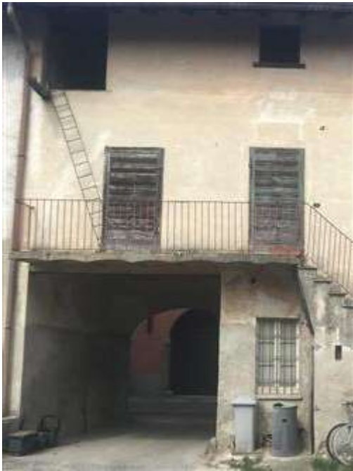
particolare andito di accesso
