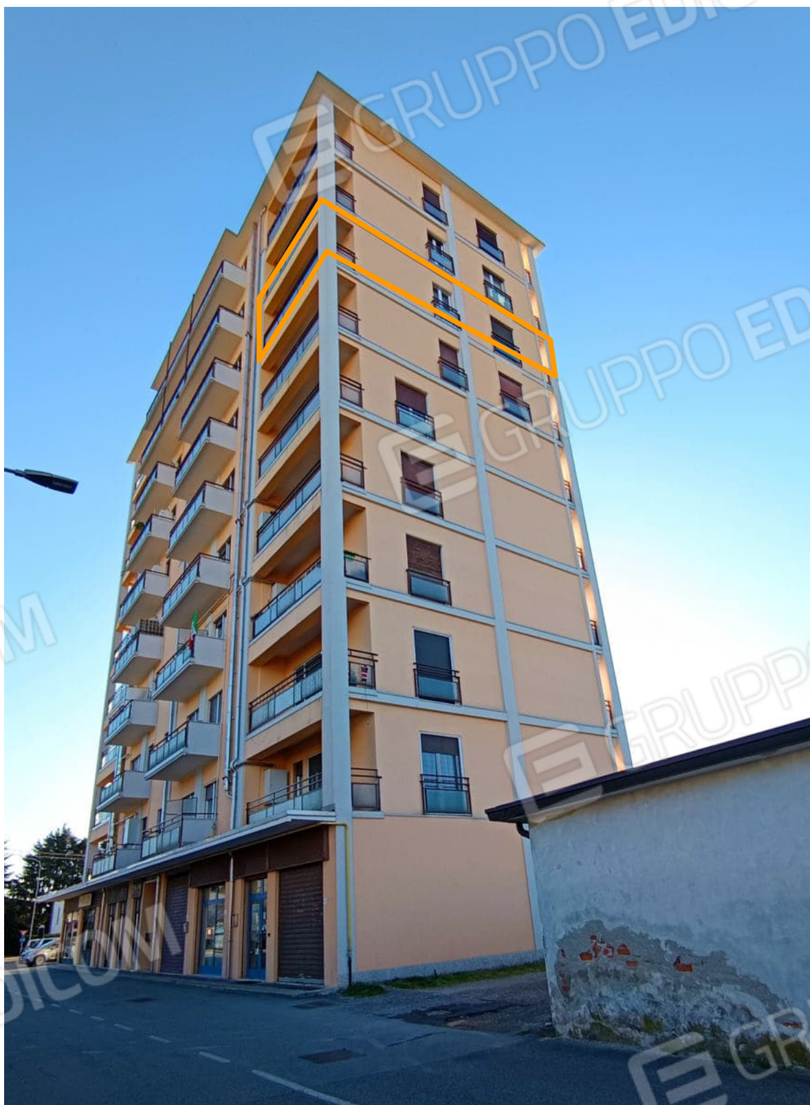
Prospetto principale su via Torino
