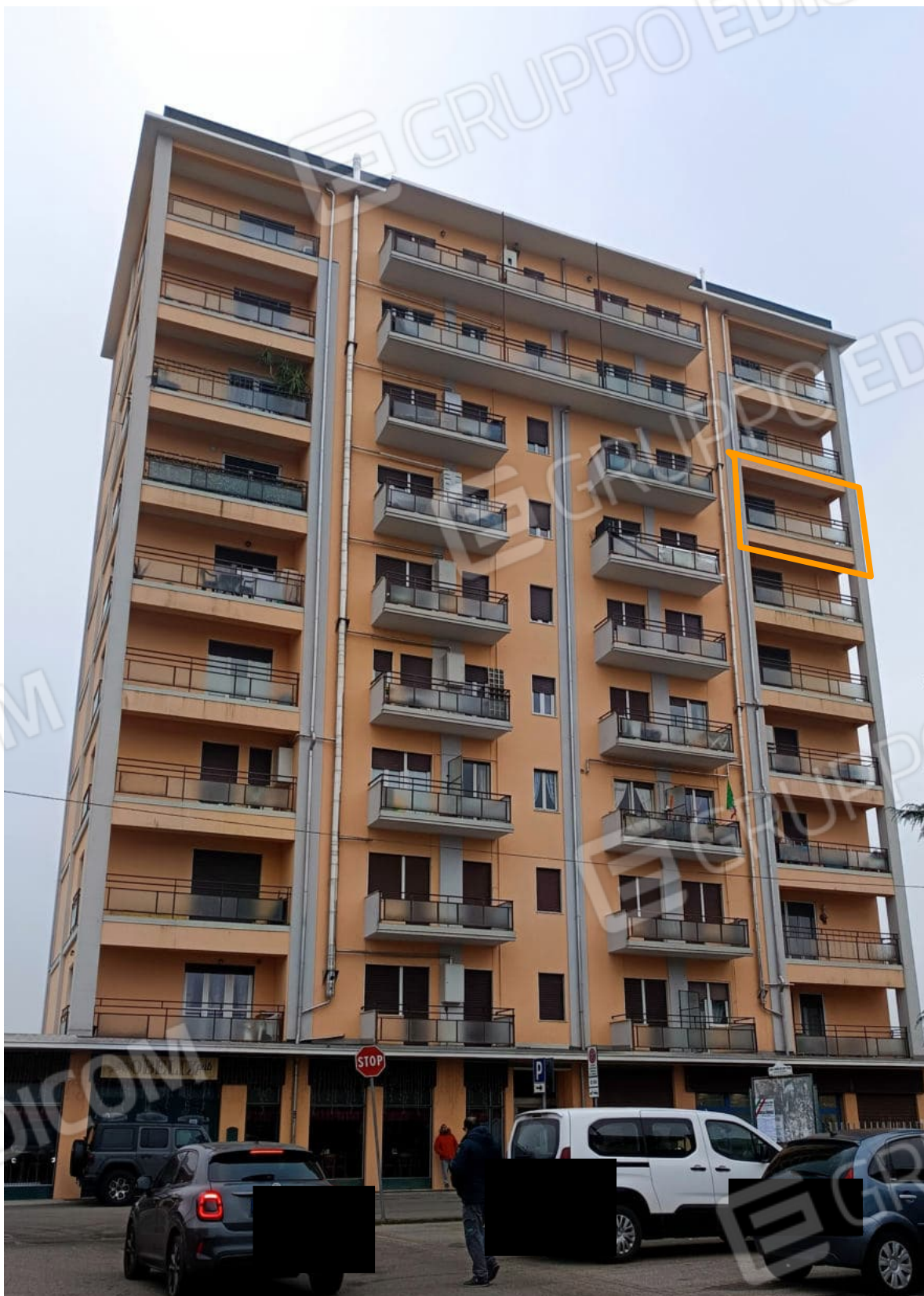
Prospetto principale su via Torino
