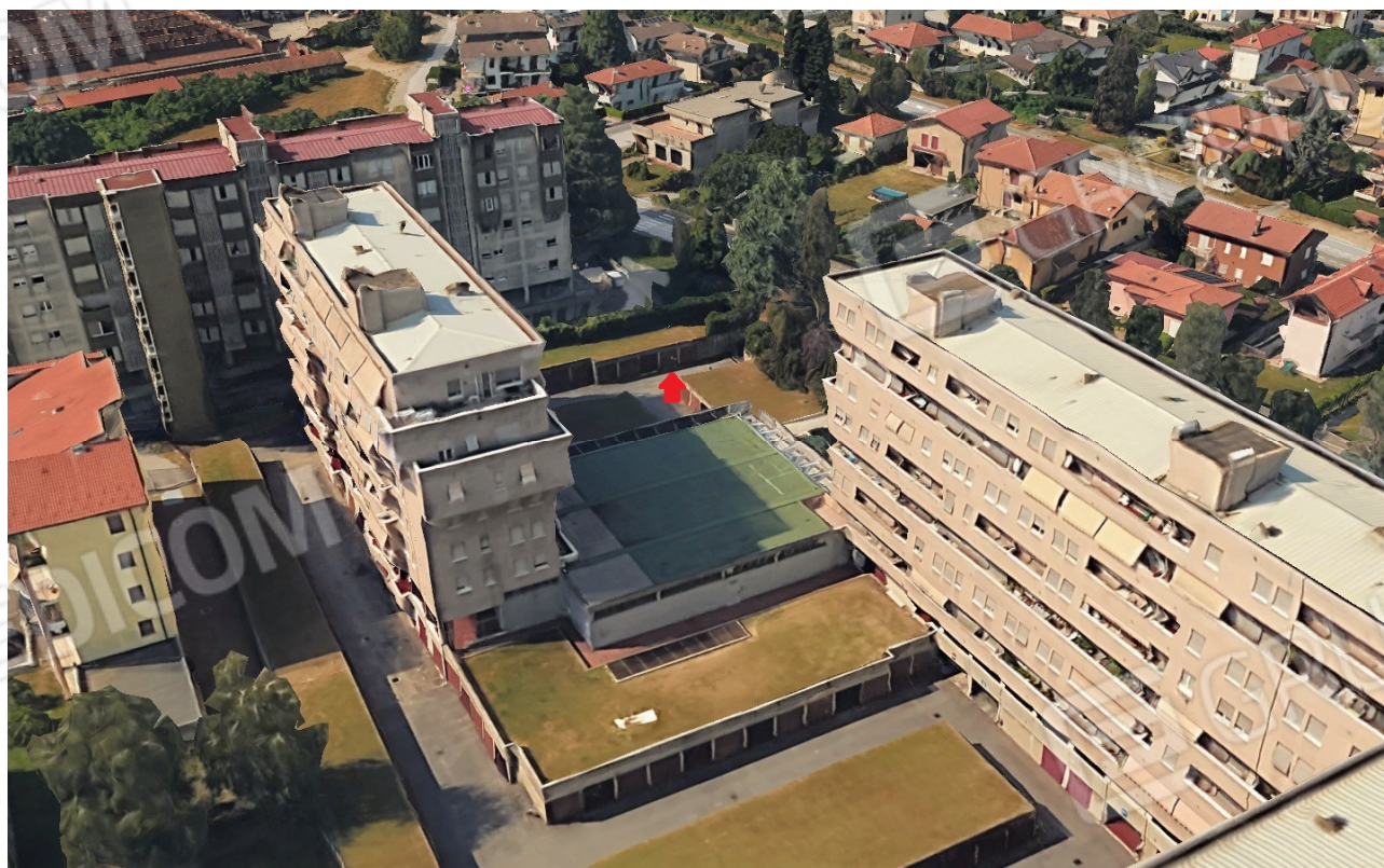
Immagine satellitare (Edificio "A", autorimessa)
