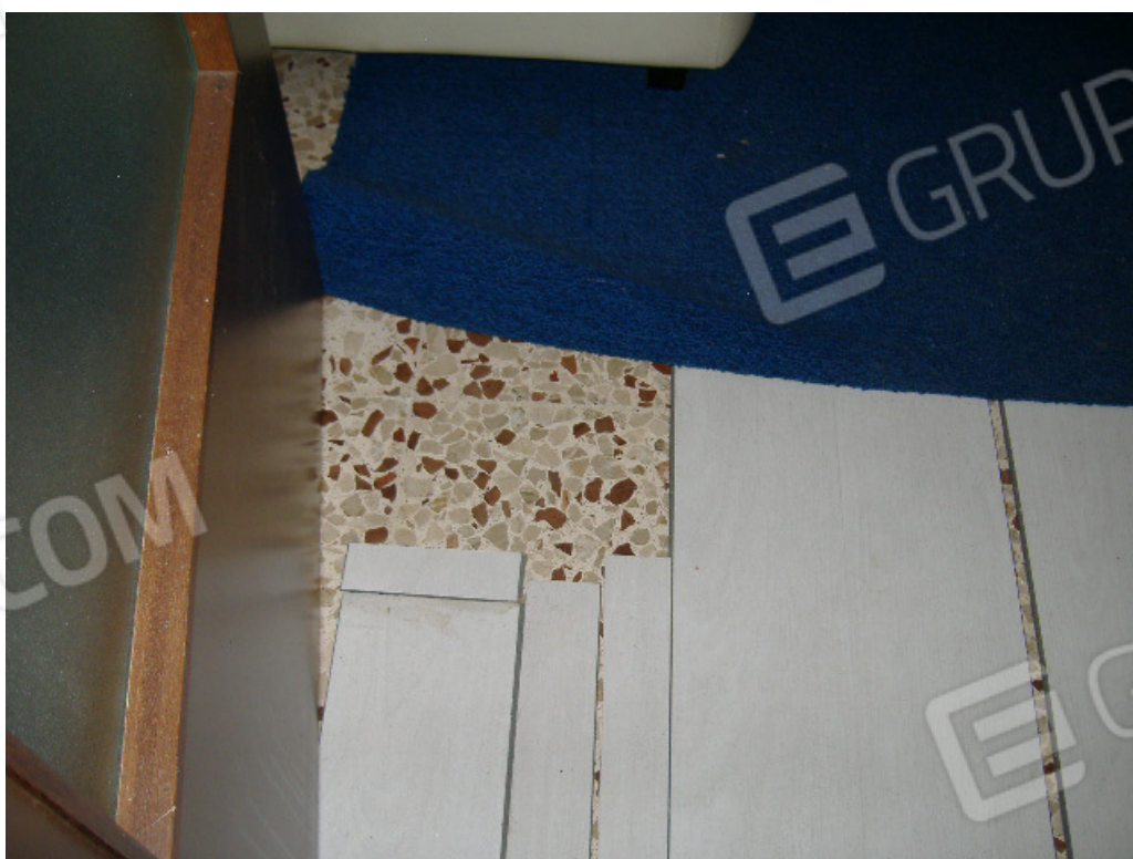
Locale 2 (particolare pavimento)
