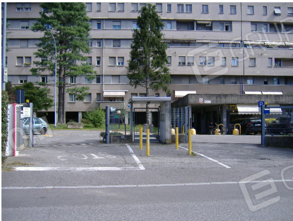
Accesso pedonale e carraio (Strada Pradisera)
