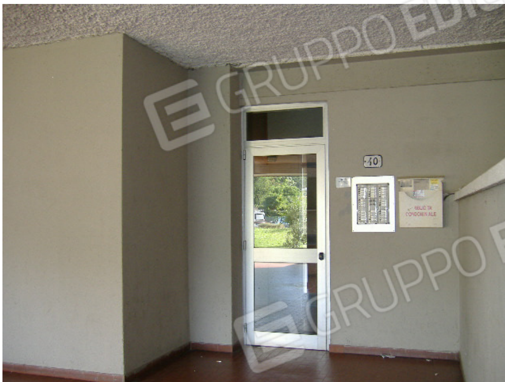
Accesso al vano scala e ascensore comune
