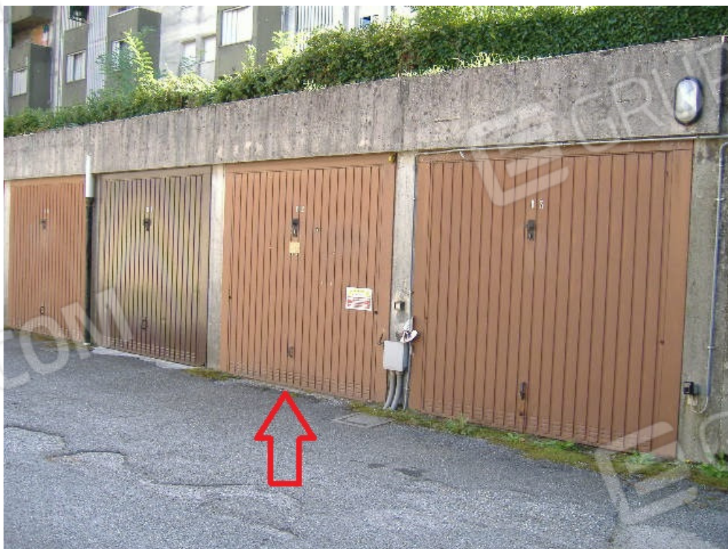
Autorimessa (Edificio "A", P.S1, n. 12)
