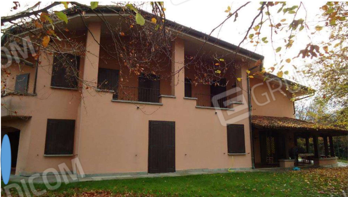
5. Prospetto nord-ovest – dettaglio terrazza piano primo
