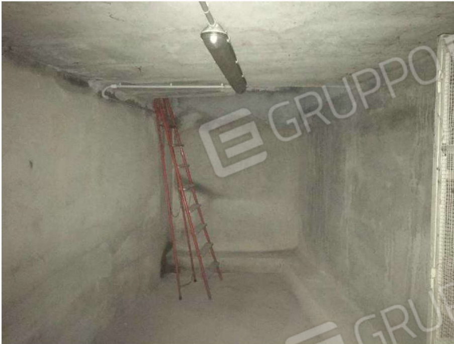
18. DETTAGLIO OPERE SVOLTE: botola di collegamento piano interrato-autorimessa
