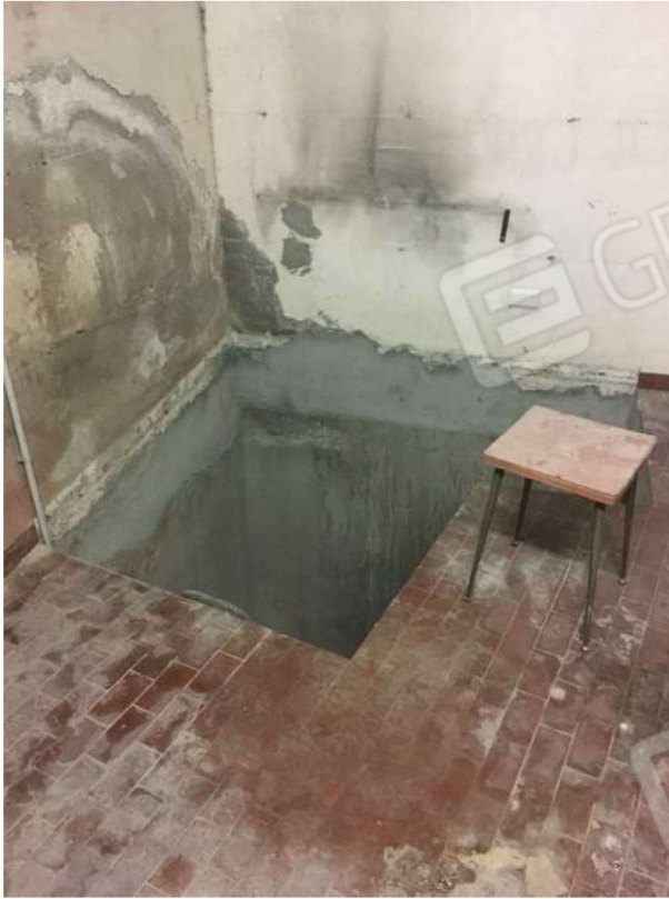
20. DETTAGLIO OPERE SVOLTE: botola di collegamento piano interrato-autorimessa
