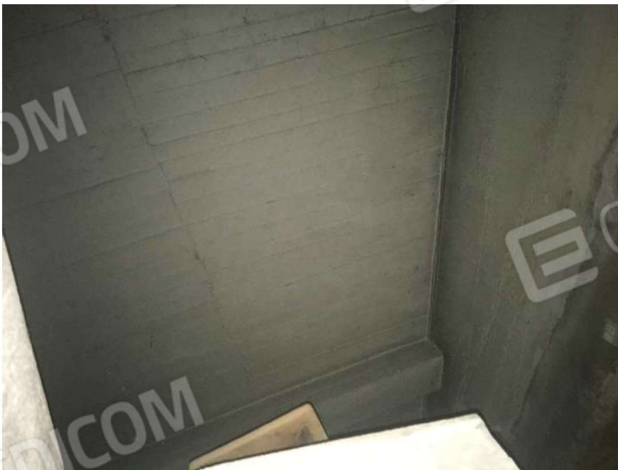
19. DETTAGLIO OPERE SVOLTE: botola di collegamento piano interrato-autorimessa
