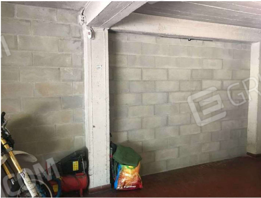
29. DETTAGLIO OPERE SVOLTE: nuovo divisorio autorimesse
