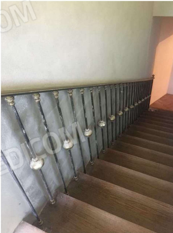
27. DETTAGLIO OPERE SVOLTE: nuovo divisorio su scala di collegamento piano rialzato/autorimessa
