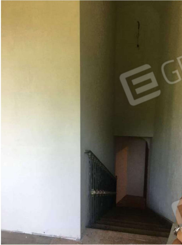
26. DETTAGLIO OPERE SVOLTE: nuovo divisorio su scala di collegamento piano rialzato/autorimessa
