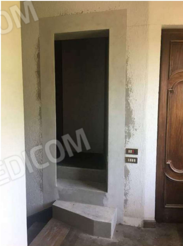
25. DETTAGLIO OPERE SVOLTE: nuovo accesso camera da letto piano terra/rialzato
