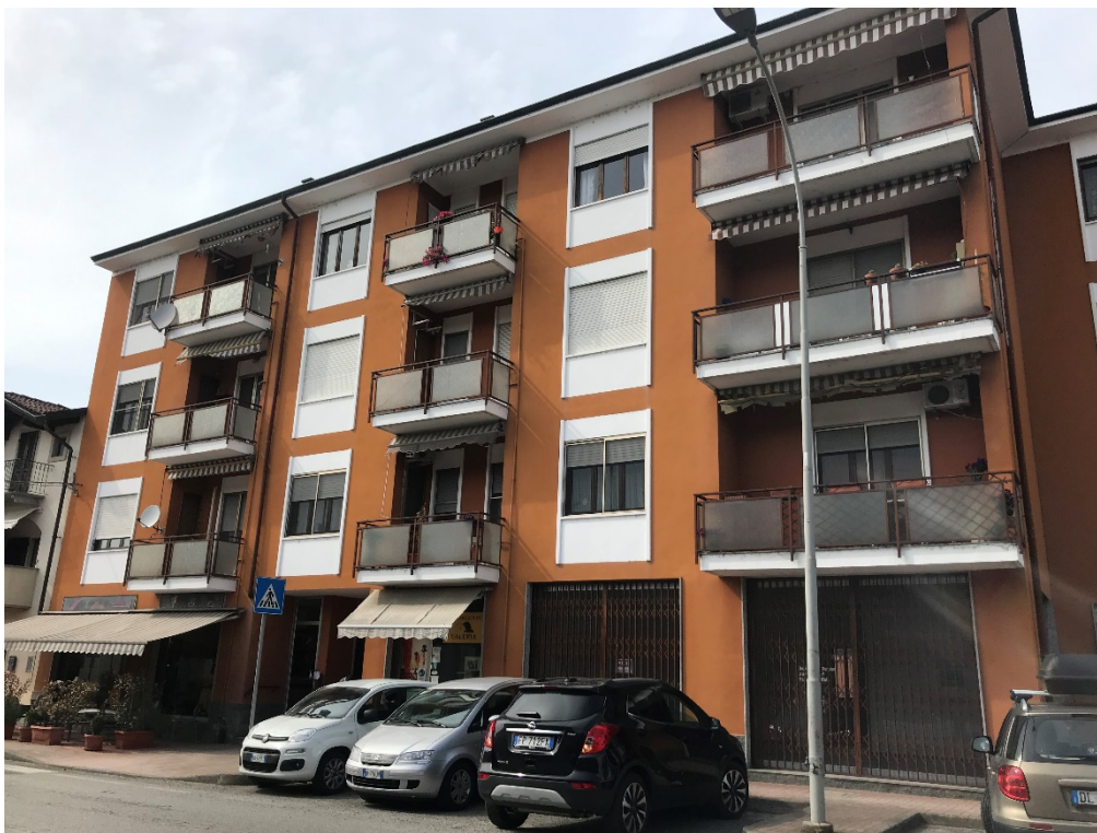
Foto n. 2: Prospetto principale su Via Umberto I
