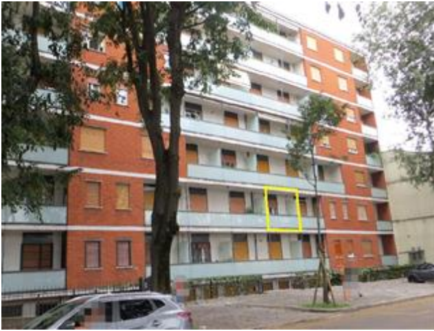
L'affaccio Est della palazzina
