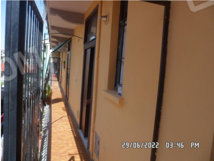
Ballatoio comune e ingresso all'unità immobiliare
