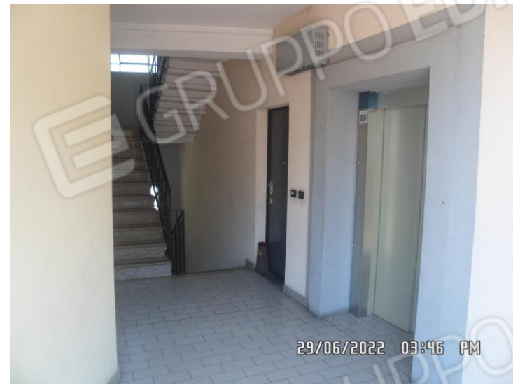
Vano scala comune
