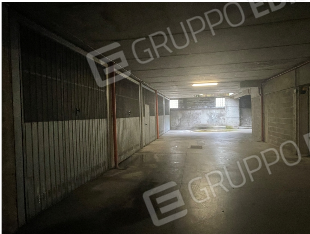
corsello di manovra
