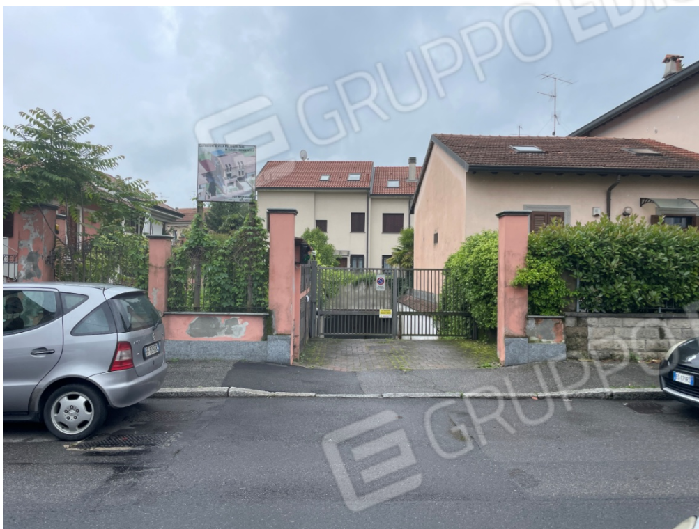
accesso dal civ.34/B di Via R. Ardigò
