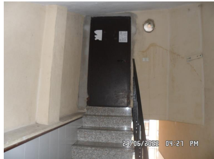
Accesso comune solai
