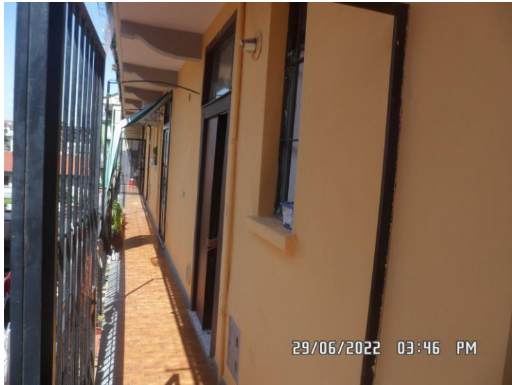
Ballatoio comune e ingresso all'unità immobiliare
